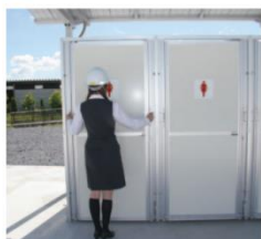
⑤前面パネル(扉)を蝶ボルト4点で固定。
