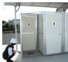
③側面パネルを固定し、斜め材を取付。
