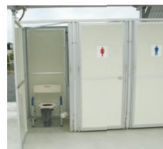
⑥マンホールを開け、便器を設置。
